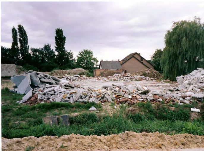
Boerderijen werden gesloopt
